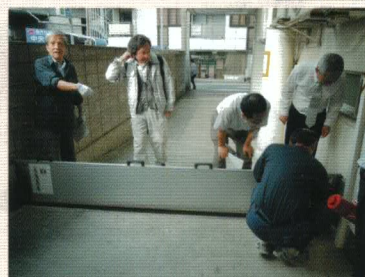
← 1号館通用口の防潮板設置
