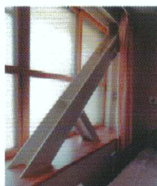
鉄骨ブレース補強
